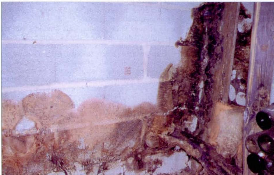
Photographie 1 : Un spectacle que nous ne vous souhaitons pas chez vous : dans cette cave excessivement humide, la mérule ( Serpula lacrymans ) s'est d'abord implantée sur du bois, mais elle a envahi également les parpaings et même les étiquettes des bouteilles de vin !
