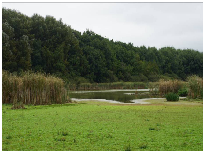
Photo 12. Bassin de végétation en cours d'assèchement, © G. ARNAL
