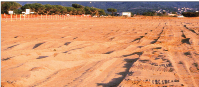
Photo c - Aspect du terre-plein après le décapage de la couche de terre (2001). (Photo F. GALLERAS, Cdl).
