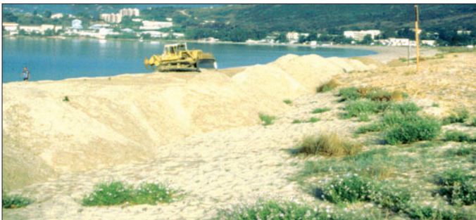
Photo d - Mise en place du sable pour la création du bourrelet pseudo-dunaire (2001). (Photo F. GALLERAS, Cdl).
