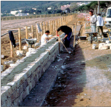
Photo a - Construction du muret (2001). (Photo F. GALLERAS, Cdl). On comparera avec la photo 1.
